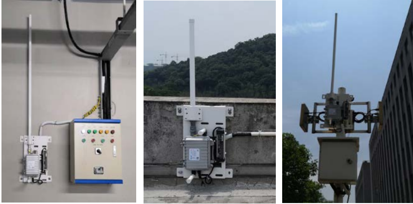
图 6 网关室内、外安装案例
